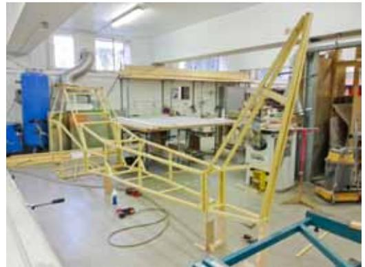
L'ensemble nécessite 150 mètres de tasseaux de 3 x 3 cm d'épaisseur. Ils sont découpés puis assemblés grâce à de la colle à bois et des clous enfoncés grâce à une cloueuse à air comprimé.
